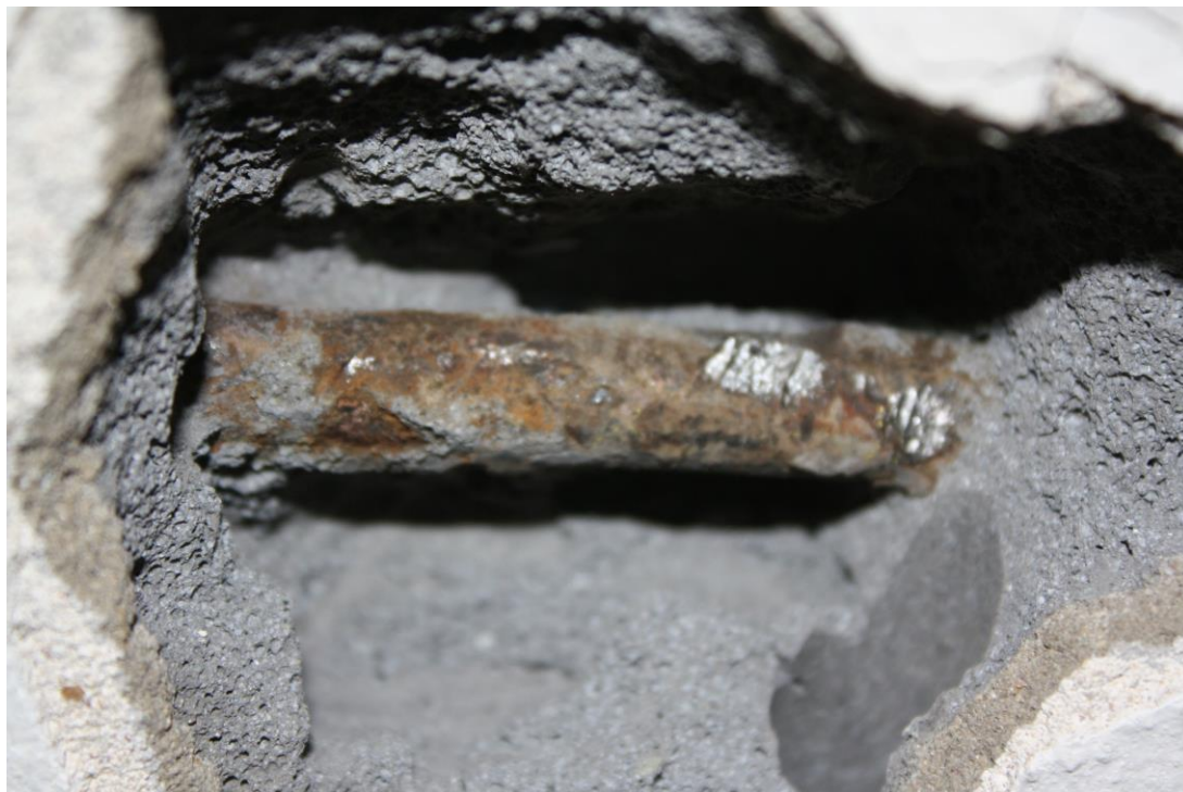
Obrázok č.3 Korózia výstuže panela
