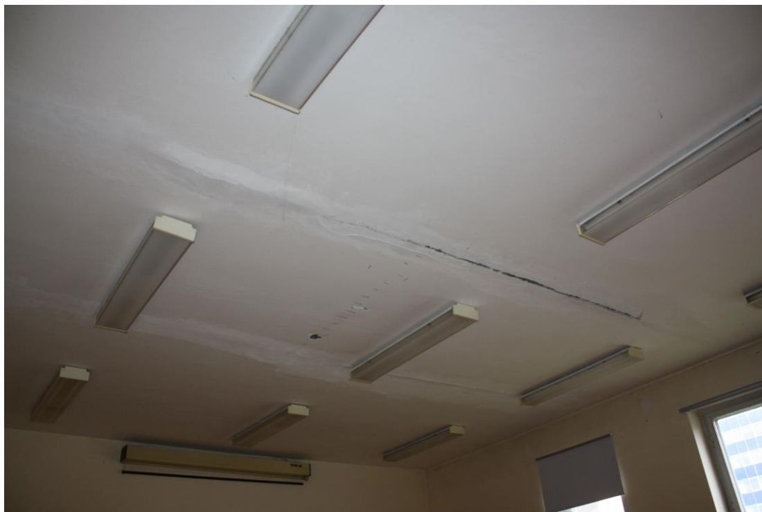
Obrázok č. 2 Pohľad na odpadnutú omietku v miestach styku panelov
